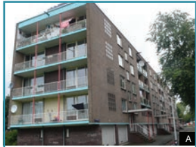
Woningcomplex Dunantstraat P. Zanstra 1959 BMA TOP 100 BMA TOP 15
