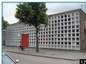
17 Autoverhuurbedrijf KAV H.A.M. van den Berg 1961
