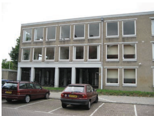
Hoofdentree aan Geelstraat.
