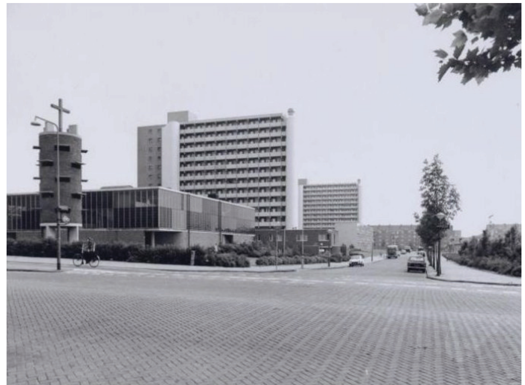
Twee flats met op de voorgrond een inmiddels gesloopte kerk, 1971.
