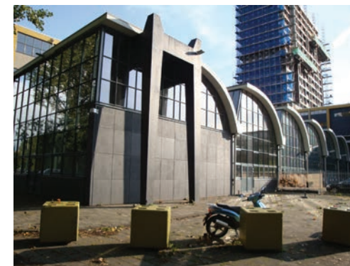
Achterkant met sheddaken.
