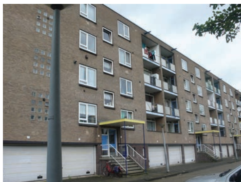
Entreepartij aan oostgevels.
