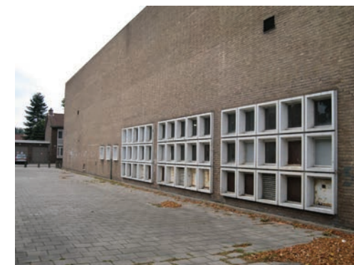
Gevel aan Hemsterhuisstraat.
