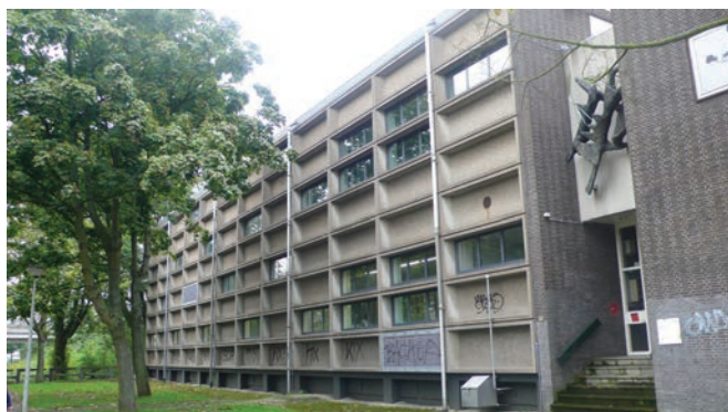
Gevel aan de Plesmanlaan.
