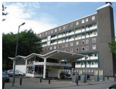
Tankstation tussen de woongebouwen.
