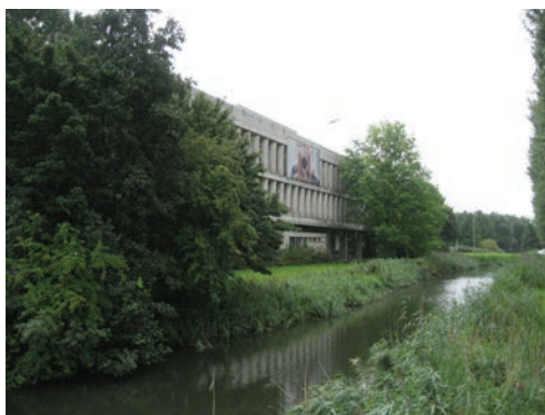
Gevel aan de spoorlijn.
