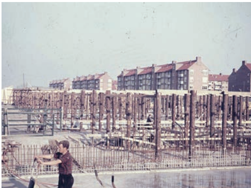
Viaduct in aanbouw, 1959.
