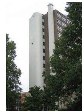
Zijgevel met noodtrappenhuis.
