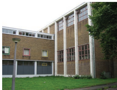
Aansluiting hoofdgebouw op gymzaal.
