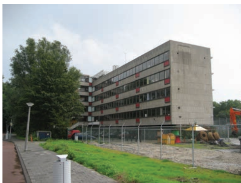
Gevel aan de Lelylaan.
