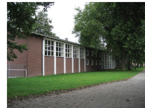
Gymzaal aan Lobo Braakensiekstraat.
