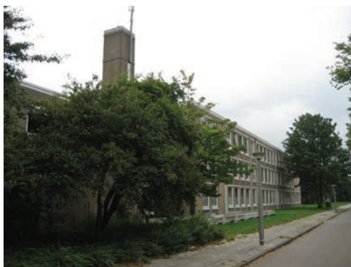
Gevel aan Geelstraat.
