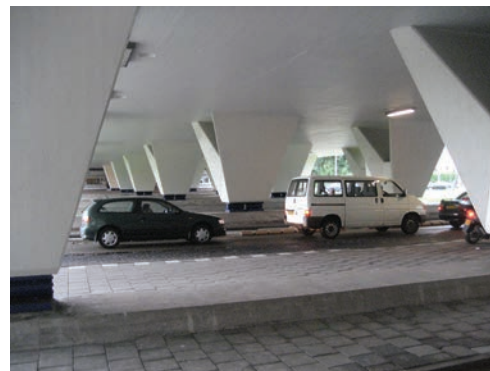
Kolommen onder het brugdek.
